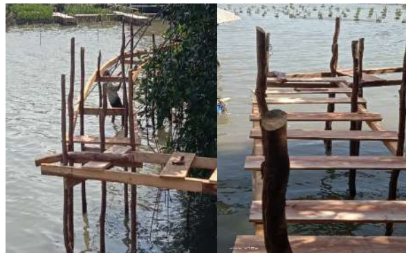
Gambar 2. Pembangunan Jalur Tracking
