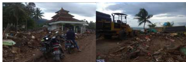
Gambar 3. Kerusakan Desa Kunjir Kecamatan Rajabasa Lampung Selatan pasca Tsunami Selat Sunda tahun 2018 (iNews Lampung, 2018)
