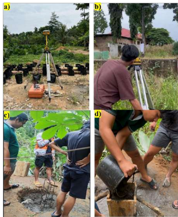
Gambar 1. (a) Pengukuran koordinat BM. (b) Pemasangan alat untuk pengukuran GCP. (c dan d) Pembuatan BM bata antara Desa Sukunegara dengan Way Galih.
