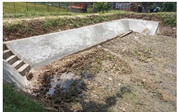
Gambar 3. Perbaikan dinding kolam oleh mitra PkM
