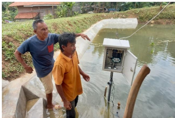
Gambar 9. Pemasangan Unit Sistem Monitoring pada kolam budidaya
