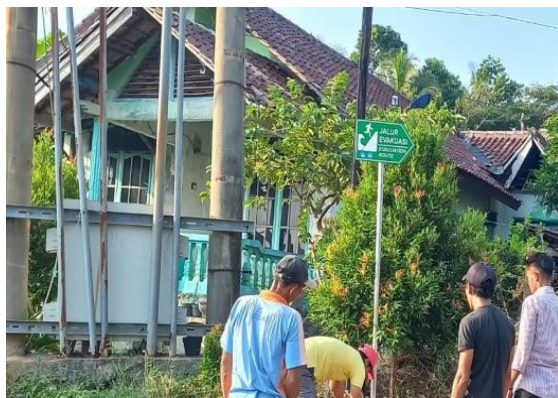
Gambar 9. Pemasangan jalur evakuasi tsunami Desa Batu Balak
