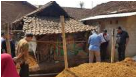
Gambar 9. Lokasi pembuatan septictank
