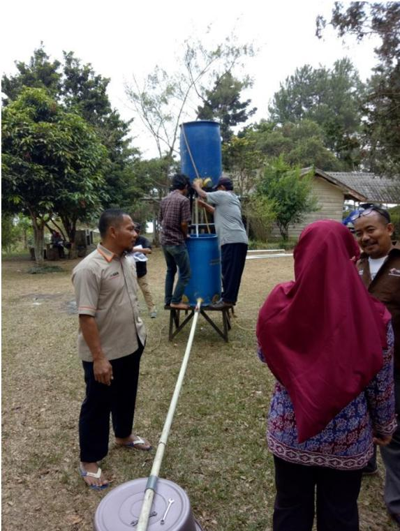
**Gambar 6.** Tim pelaksana melakukan bagaimana pemasangan dan penyetingan untuk pengoperasian *hydram pump*.
