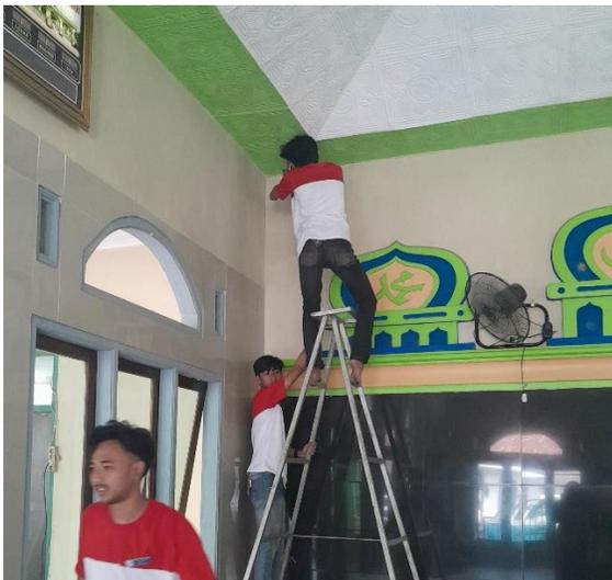
**Gambar 6.** Pemasangan lampu LED
