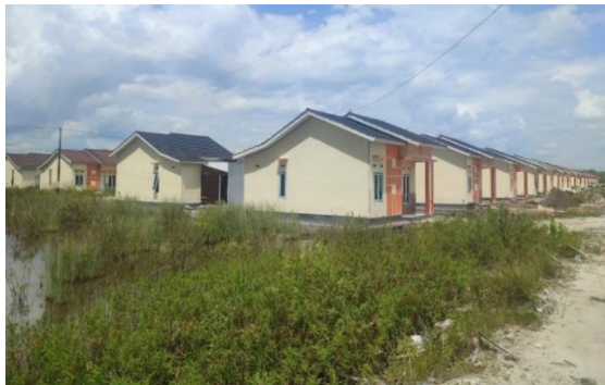
Gambar 2. Kondisi perumahan Casadova, jalan Parawei kota Palangka Raya
