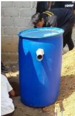
Gambar. 3. Persiapan Penggunaan Drum Plastik Bekas dalam Pembuatan Septictank
