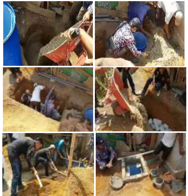
Gambar 6. Proses Pembuatan Septictank dari Drum Plastik Bekas
