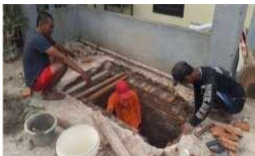
Gambar 4. Pembangunan Jamban Keluarga
